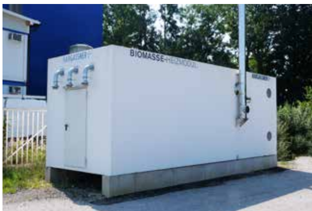
Module de chauffage simple 120kW à granulés, local commercial
